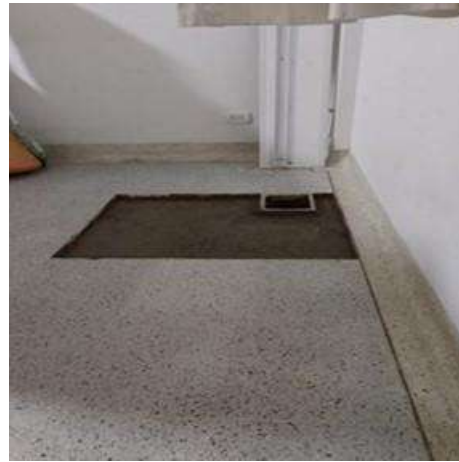
Reparación de humedad en cuarto de rayos X, producida por fuga en corredor de sala 2.
