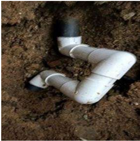
Reparación de humedad en cuarto de rayos X, producida por fuga en corredor de sala 2.
